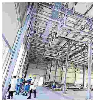
Il nuovo impianto in costruzione
